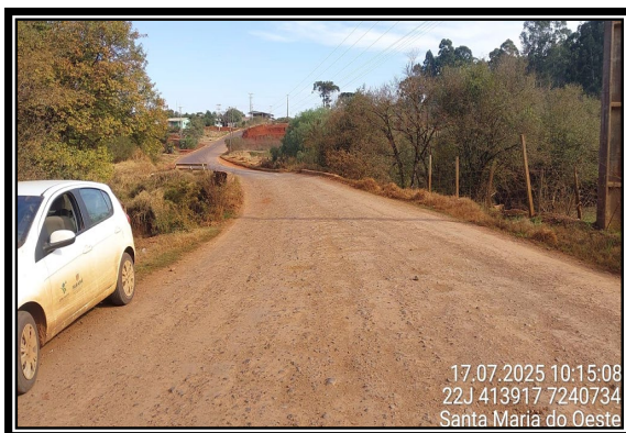
Trecho ponte Rio Santo Antônio
