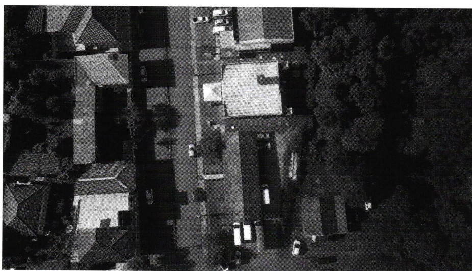
Figura 13 – Local da instalação.
