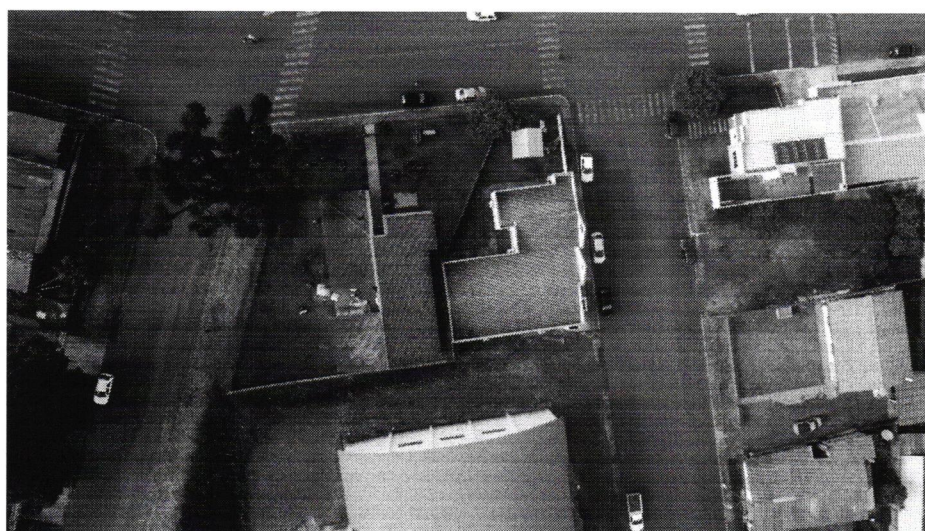
Figura 11 –Local da instalação.
