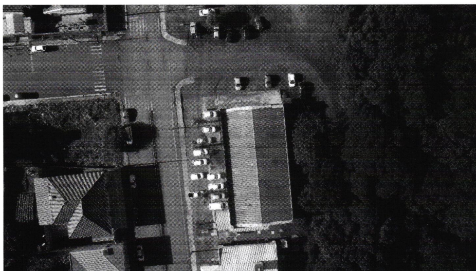
Figura 7 – Local da instalação.
