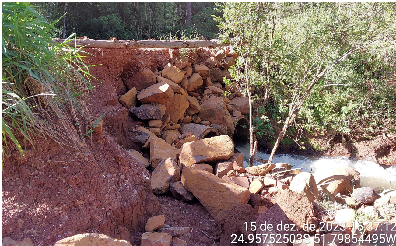
Foto 13: Construção de bueiro.
