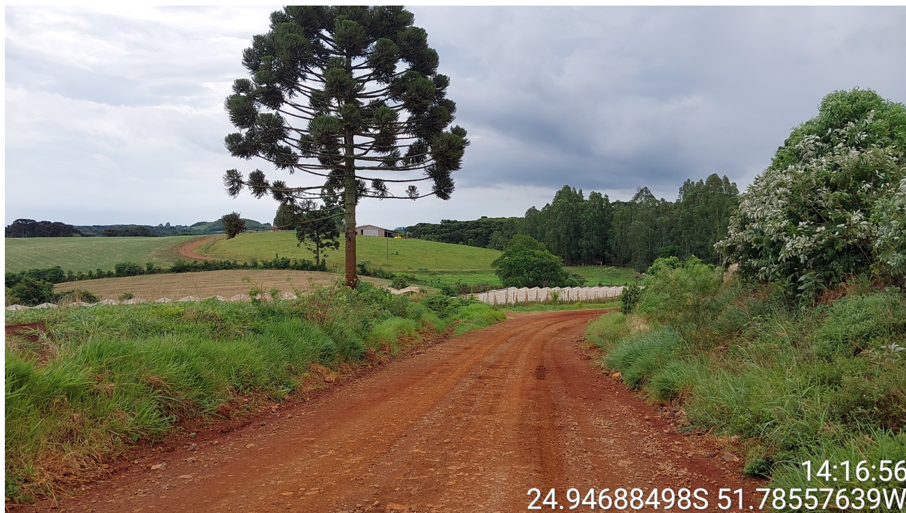
Foto 25: Trecho a ser pavimentado.
