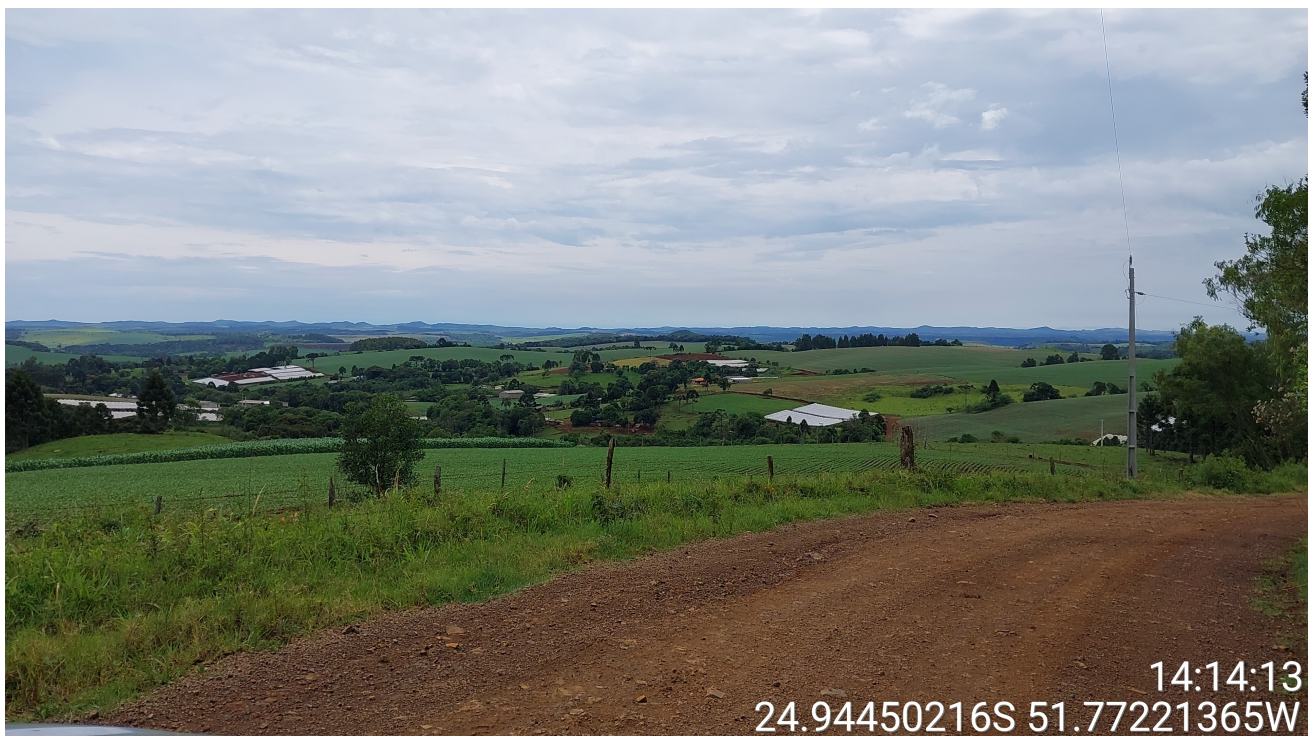
Foto 24: Trecho a ser pavimentado, Comunidade Novo Horizonte ao fundo.
