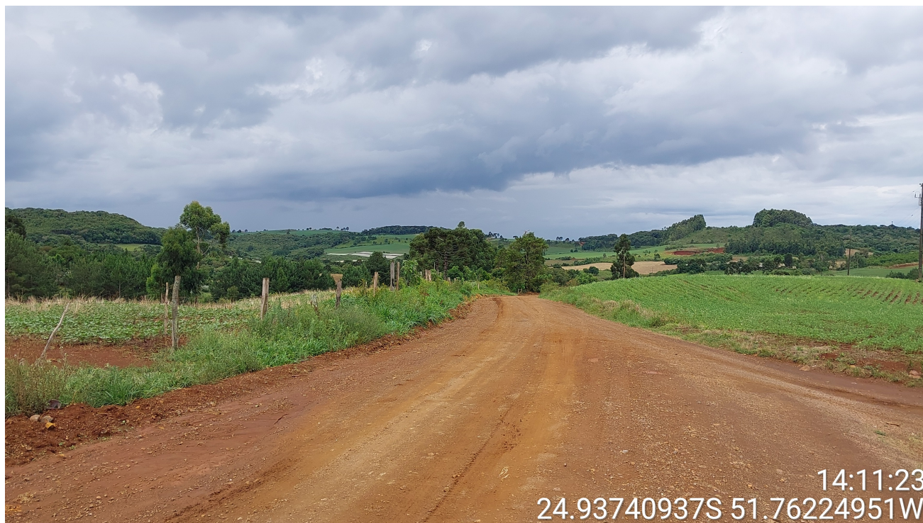
Foto 29: Final do trecho a ser pavimentado.
