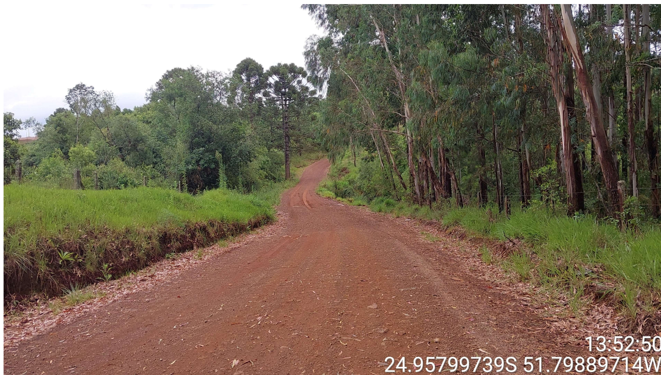
Foto 11: Trecho a ser pavimentado.
