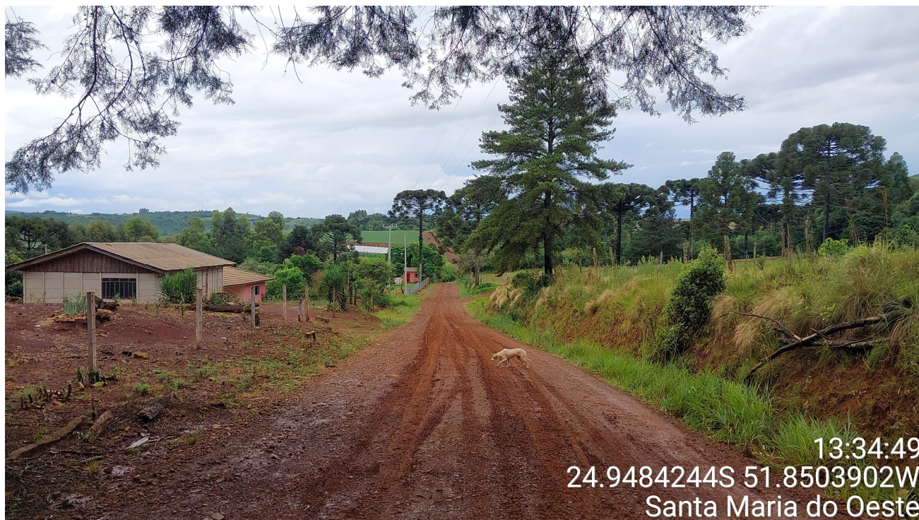
Foto 03: Trecho a ser pavimentado, área com moradias.
