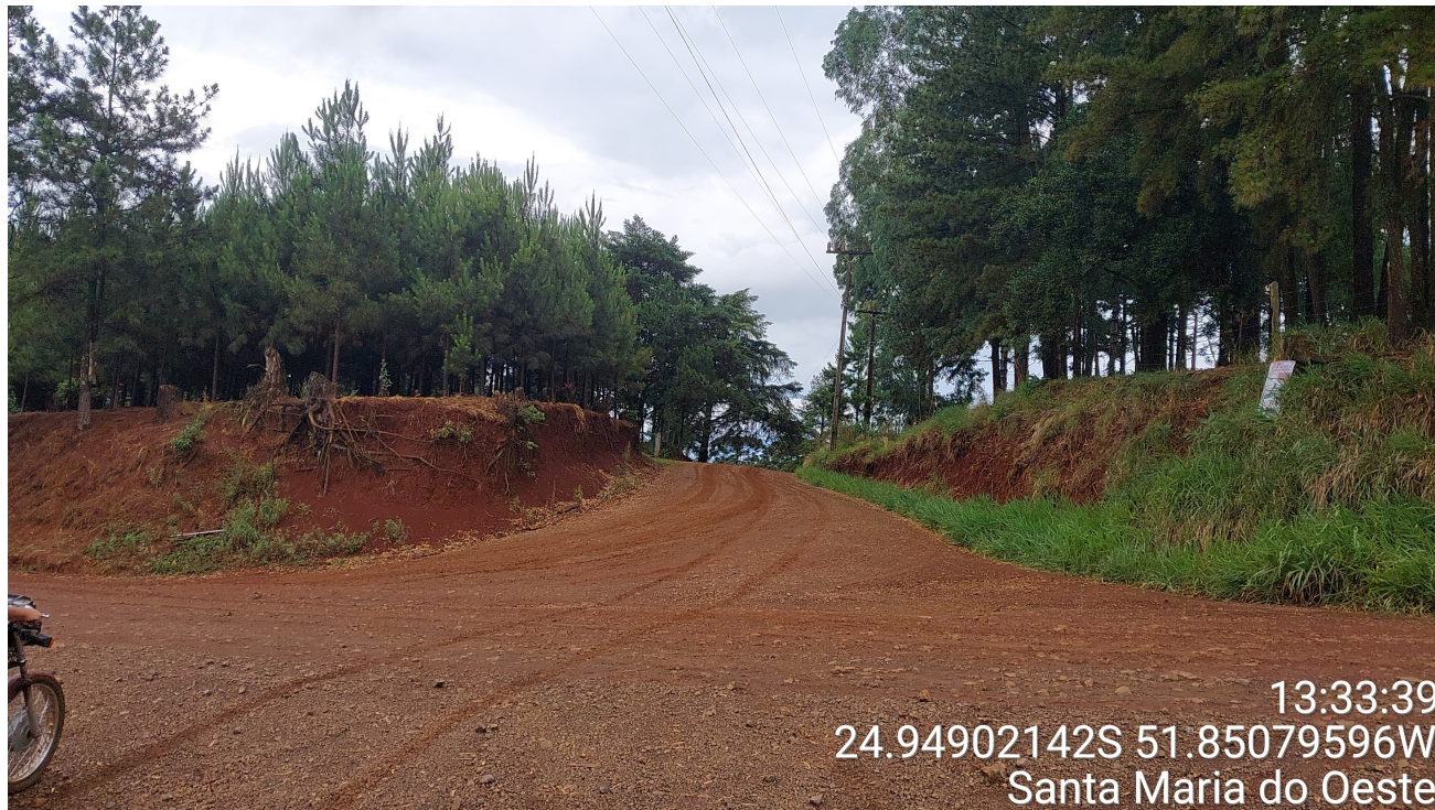
Foto 01: Início do trecho.
