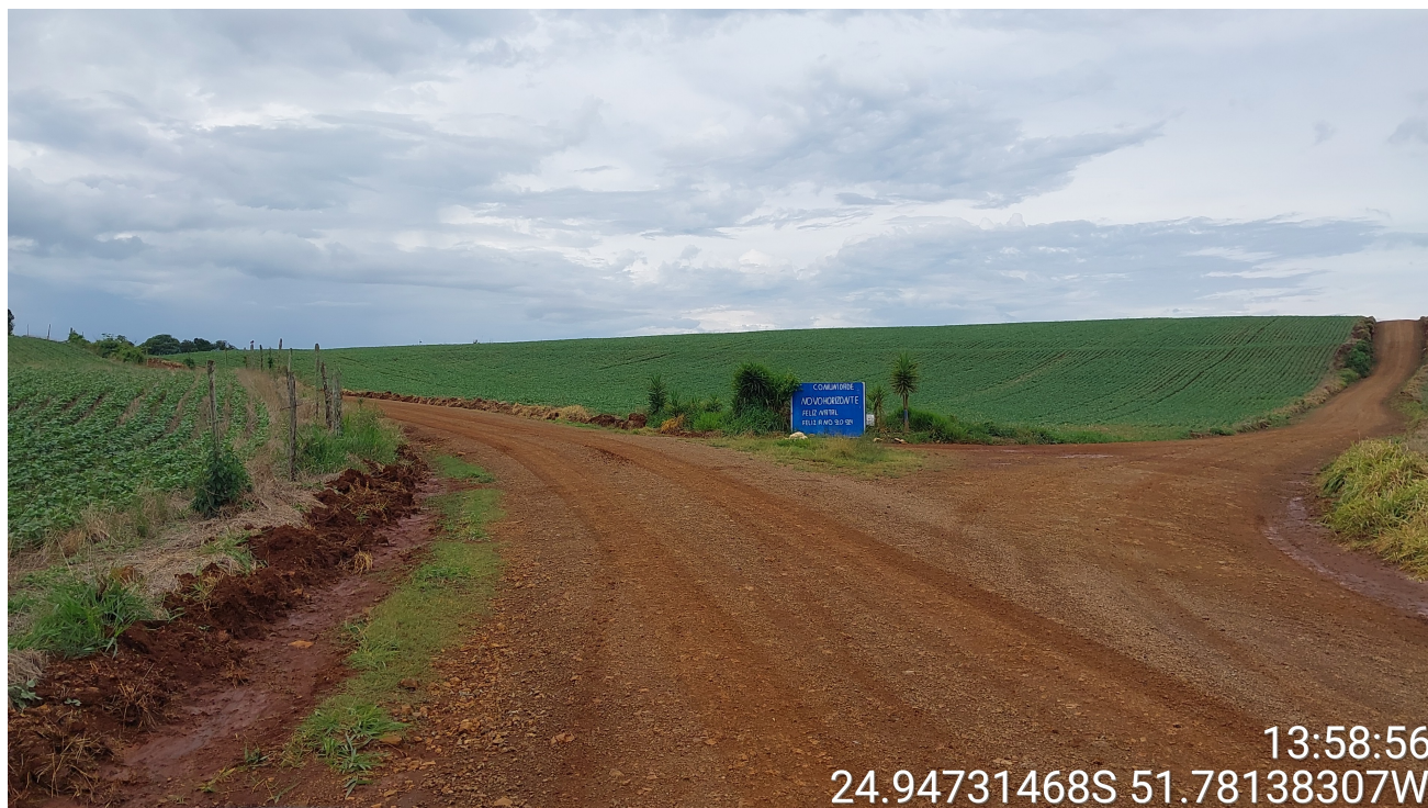
Foto 16: Trecho a ser pavimentado, área de produção agrícola e acesso a Comunidade Novo Horizonte.
