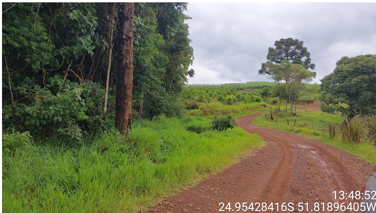
Foto 10: Trecho a ser pavimentado.
