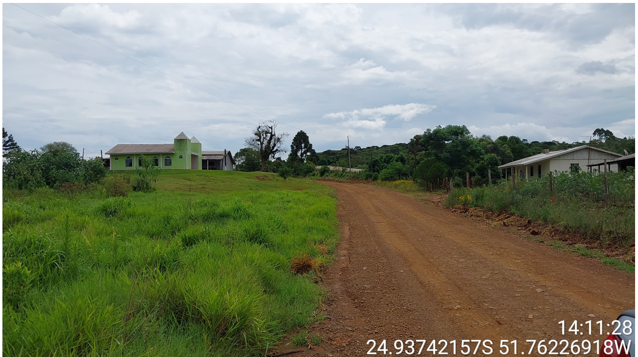
Foto 28: Final do trecho a ser pavimentado.
