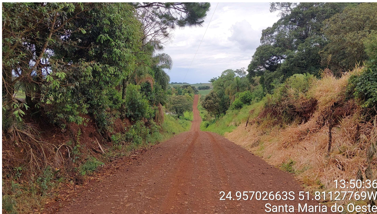
Foto 12: Trecho a ser pavimentado.
