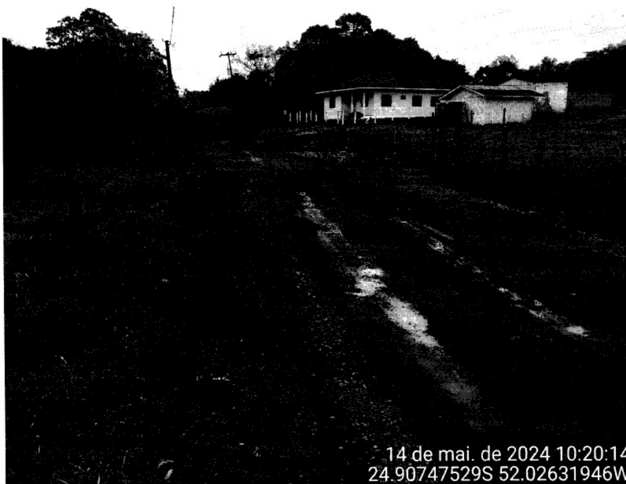
Foto 01: Final do trecho projetado e início do trecho a ser ampliado.
