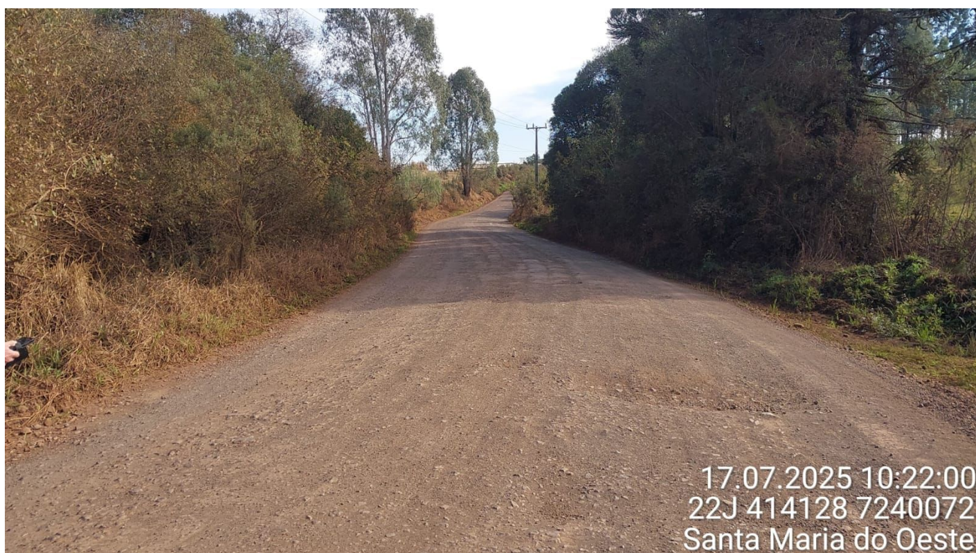
(Condições do trecho)
