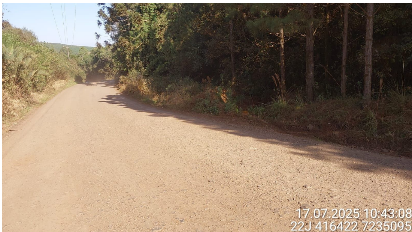
(Condições do trecho)
