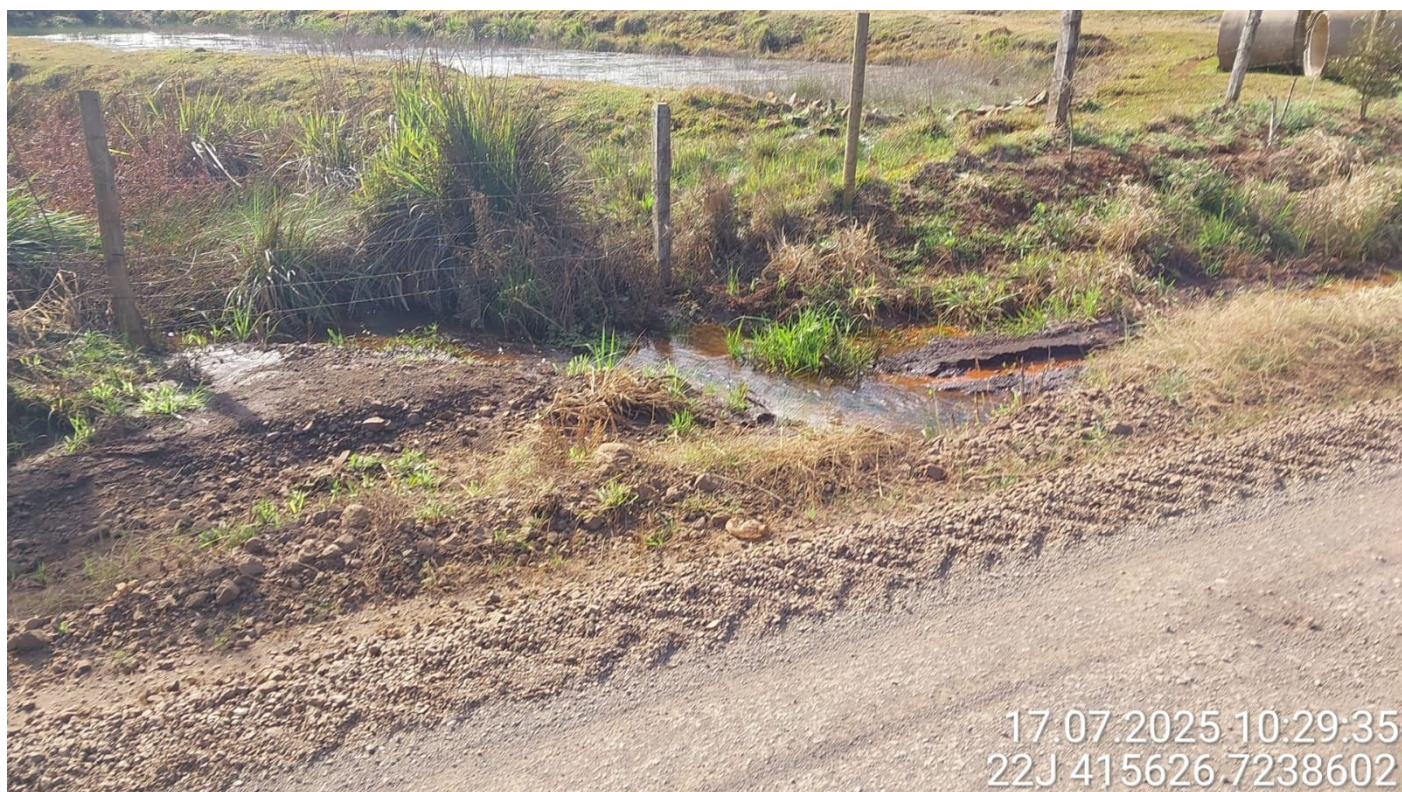
(Condições do trecho)
