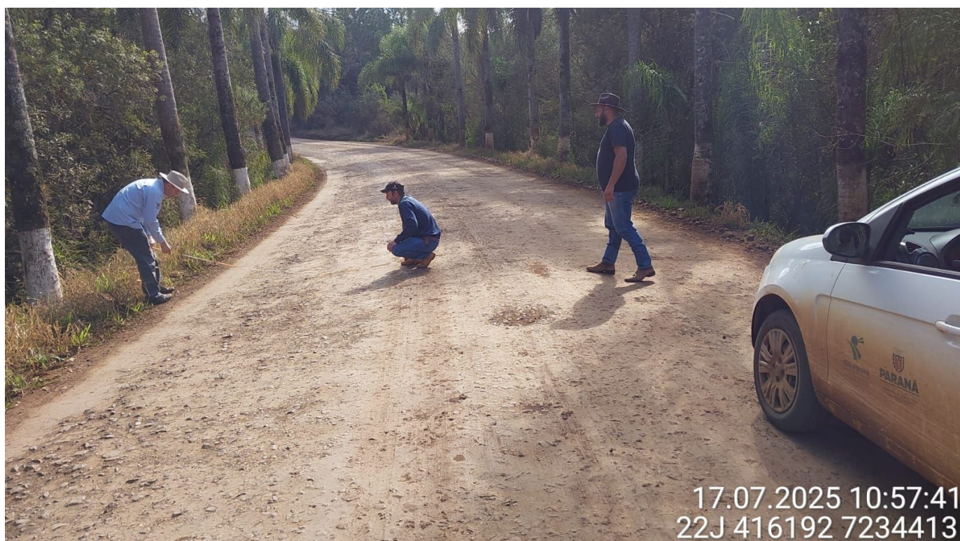
(Condições do trecho)
