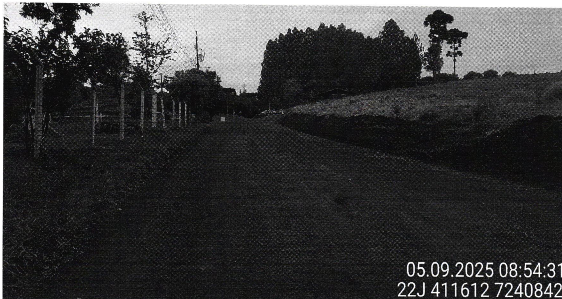
Foto 01: Trecho com drenagem a ser implantada.
