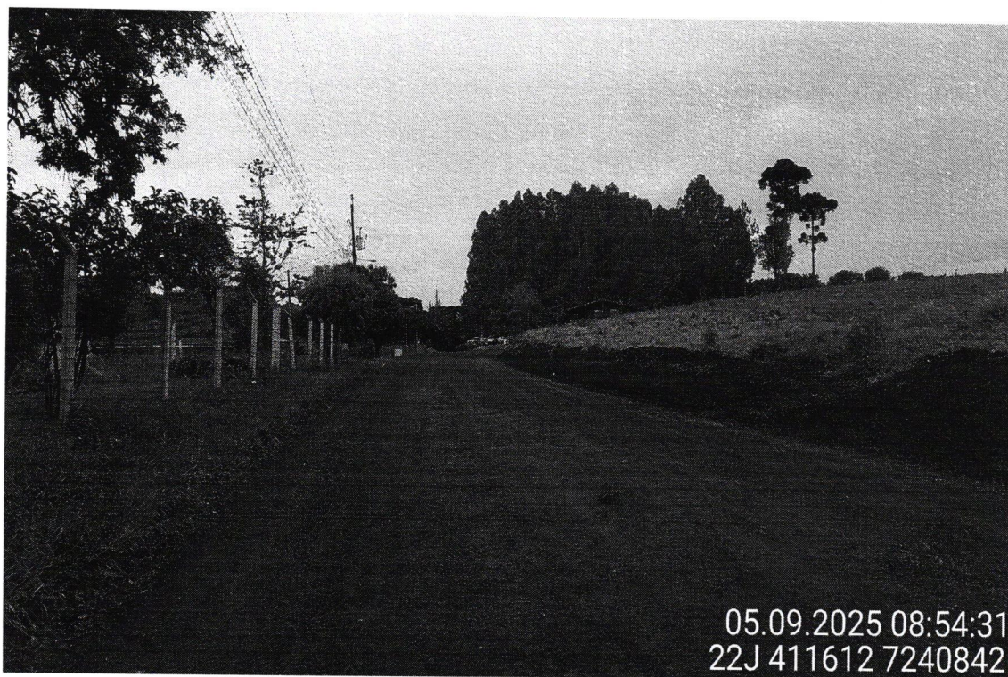
Foto 01: Trecho com drenagem a ser implantada.
