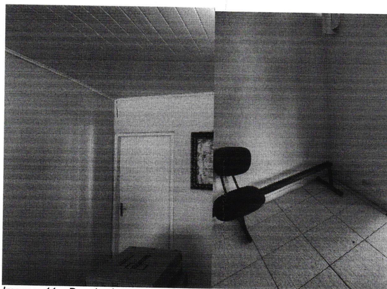
Imagem 11 – Paredes internas a serem emassadas e pintadas
