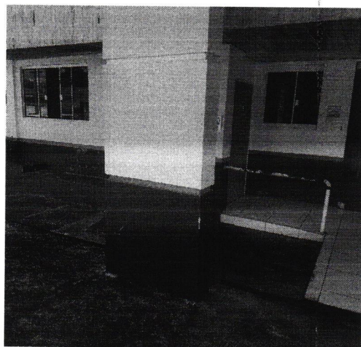
Imagem 13 – Paredes frontais a serem emassadas e pintadas
